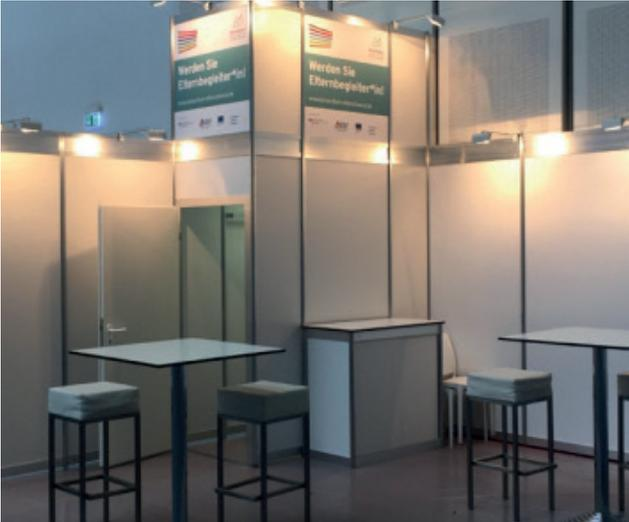
Die einfache Systemwand besteht aus Wandplatten, die zwischen Stützen eingehängt werden. Dabei können die Wände in schlichtem weiß gestaltet sein, oder farbig bezogen werden. Natürlich ist auch das Aufziehen von Bildmotiven und Schriften via Digitaldruck möglich.
